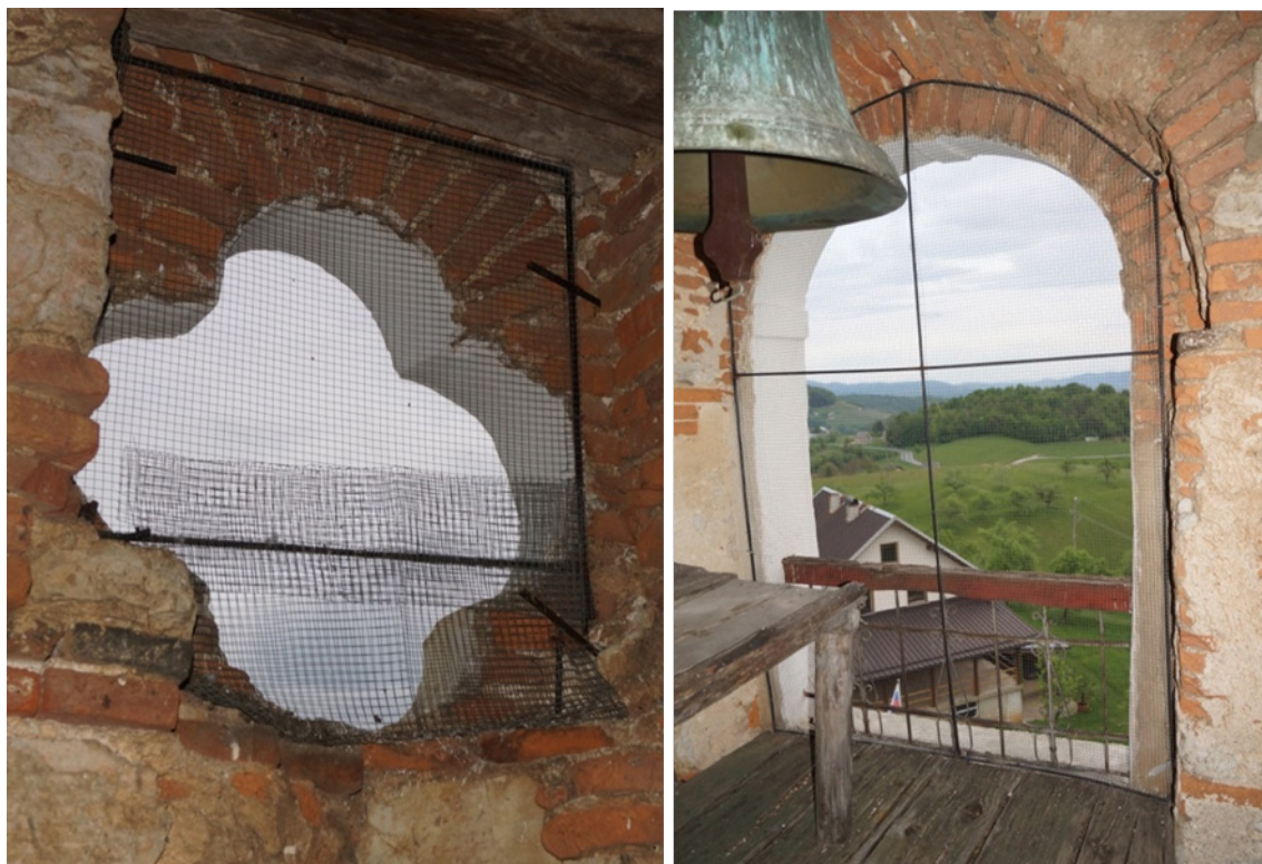
Slika 8: Špranje ob mrežah so preletne odprtine navadnih netopirjev na južnem zvoniku cerkvi v Dolnjem Suhorju pri Metliki. (foto: Aja Zamolo, 3. 5. 2019)
