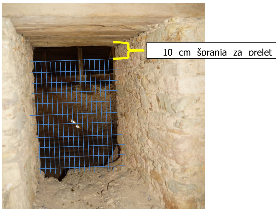
Slika 19: Možnost namestitve mrež za preprečevanje vstopa golobov v osrednjo podstreho (pogled proti stranski podstrehi).
