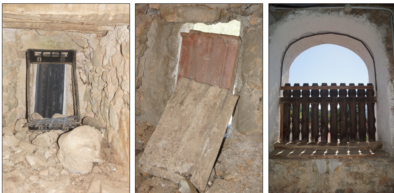
Slika 15: Zastavljeni lini v zvoniku in zamrežena okna na zvonišču cerkve sv. Neže na Lopati (foto: Aja Zamolo, 6. 7. 2017).
