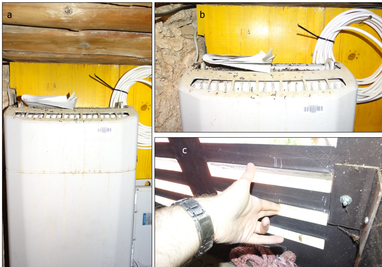
Slika 16: a) Niša s telekomunikacijskimi napravami v spodnjem delu zvonika sv. Ane v Gozdu, b) toplota nad napravami je verjetno privabljala netopirje, da so viseli nad napravami in jih posledično onesnaževali z gvanom, c) za netopirske prelete preozke letvice na polkni zvonika (foto: Primož Presetnik, 29. 8. 2017).
