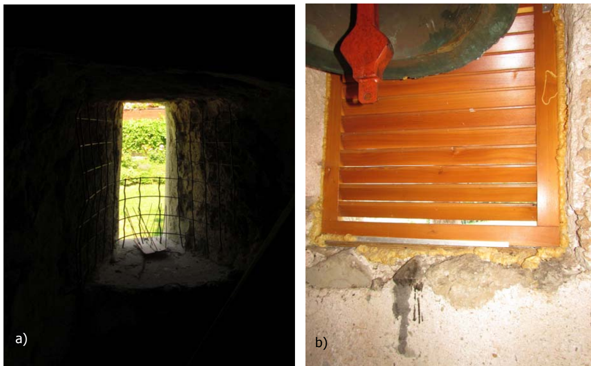
Slika 16. Učinkoviti ukrepi za preprečevanje dostopa golobom v cerkev sveti Mihael v Iški vasi: a) polzamrežena lina v zvoniku z zaščitnimi špicami proti golobom, b) polkna v zvonišču z zaščitnimi špicami na zunanji polici okna (foto: Primož Presetnik, 28. 6. 2014).
