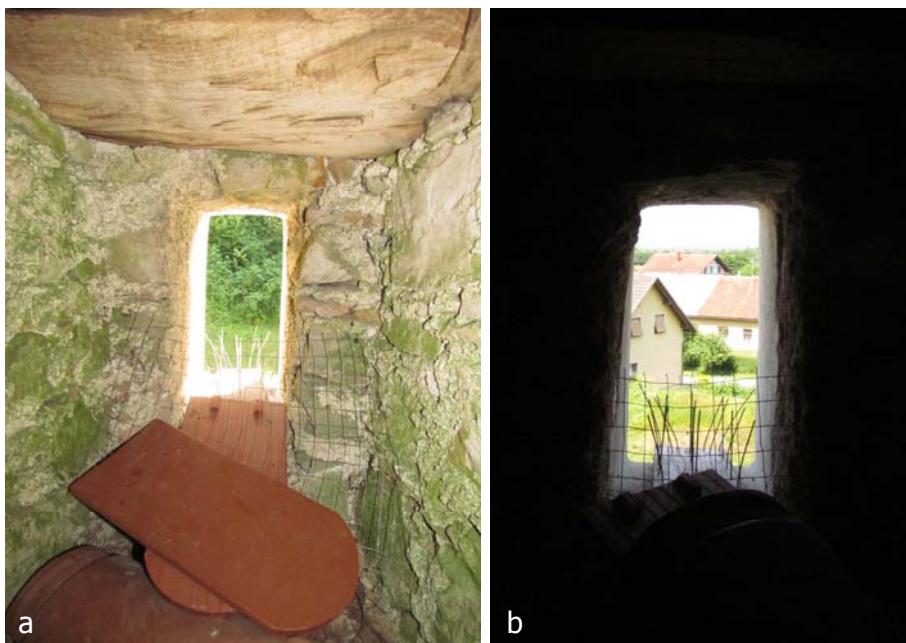
Slika 20. Delno zamrežene line v zvoniku in namestitvev bodic proti pristajanju golobov (a - spodnja lina proti gozdu in b - zgornja lina proti cesti). (foto: Primož Presetnik, 30.6.2012).
