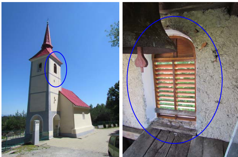
Slika 35. Posebno polkno za vstop netopirjev na zvoniku cerkve sv. Ožbolt v Dragovanji vasi. (foto: Primož Prešetnik, 26.5.2011)
