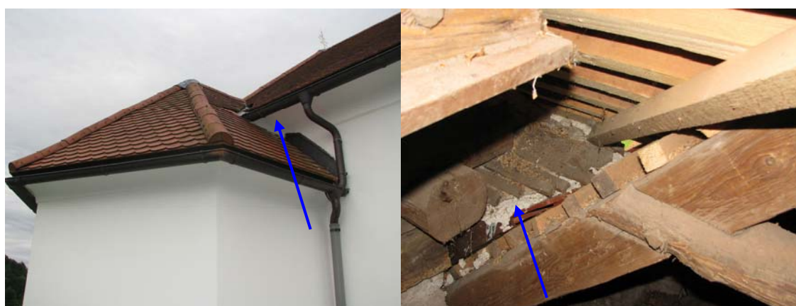
Slika 30. Na stiku strehe zakristije in strehe ladje bi se dalo obstoječo špranjo (desno) razširiti in vzpostaviti dovolj veliko odprtino za prelet malih podkovnjakov. (foto: Monika Podgorelec, 24.6.2011)
