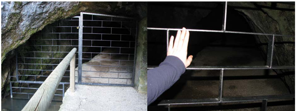
Slika 9. Nove rešetke na vhodu jame Pekarjama omogočajo bolj neoviran prelet netopirjev. (foto: Monika Podgorelec, 25.3.2011)
