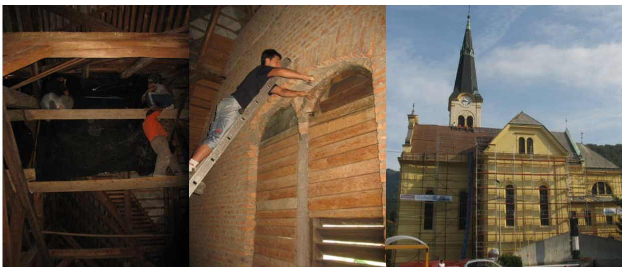
Slika 14. Napenjanje folije pod slemenom, odstranjevanje mreže s polken ter delno prenovljeno ostrešje cerkve sv. Jakoba v Dolu pri Hrastniku (foto: Primož Presetnik, 25. 8. in 29. 8. 2009).
