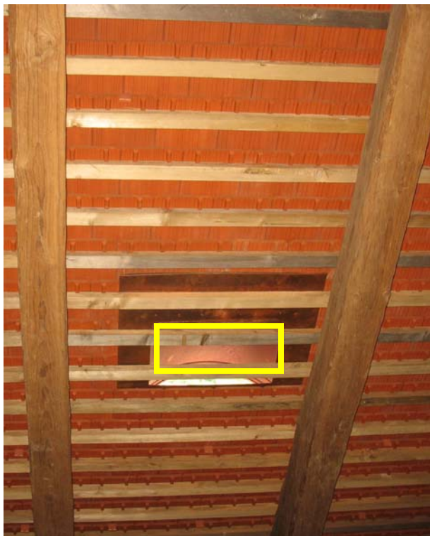
Slika 24. "Zračniki" oz. "netopirske odprtine" na SV strani strehe cerkve sv. Peter in Pavel v Brestanici bi morda lahko služili kot preletne odprtine za netopirje, vendar so pregrajeni s strešnimi letvami. Z rumenima kvadratoma so označeni deli, ki bi se morali nujno porezati (foto: Primož Presetnik, 27.6.2009).
