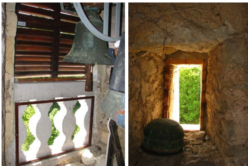
Slika 16. Polkna in z neustrezno mrežo zaprta stebričasta ograja na zvonišču ter zamrežena spodnja lina v zvoniku cerkve sv. Janeza Krstnika v Letušu (foto: Monika Podgorelec, 5.8.2009).
