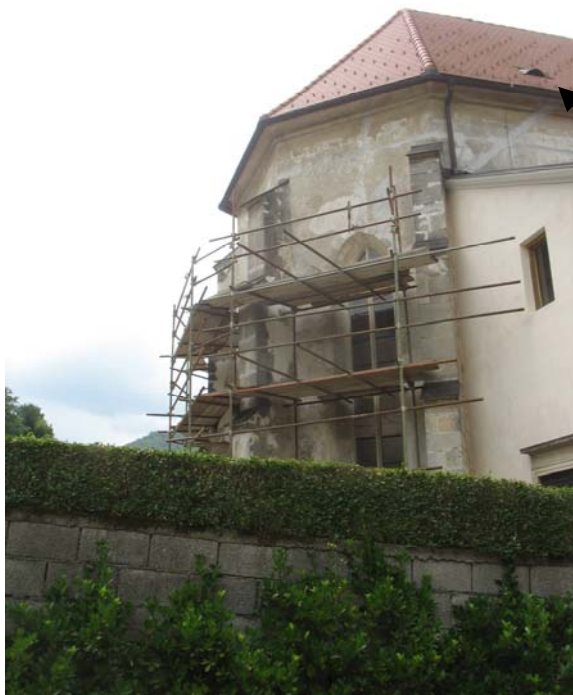
Slika 23. Eden od zračnikov na SV strani podstrehe cerkve sv. Peter in Pavel v Brestanici (foto: Primož Presetnik, 27.6.2009).
