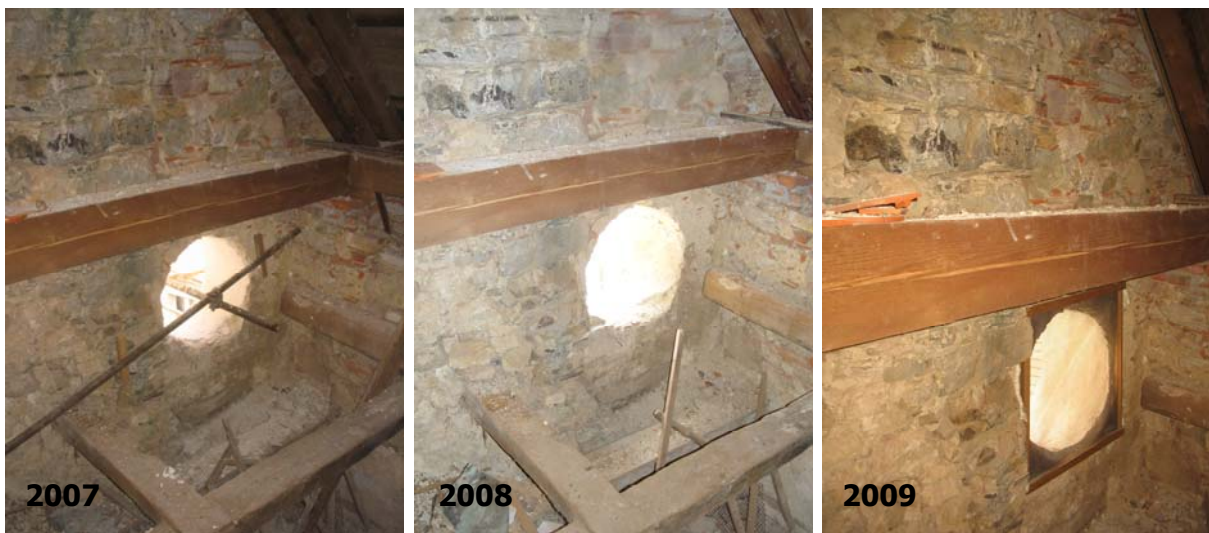
Slika 22. Stanje zamreženosti okroglih lin na podstrehi cerkve sv. Peter in Pavel v Brestanici v letih 2007, 2008 in 2009 (foto: Primož Presetnik, 7.6.2007, 10.6.2008, 27.6.2009).
