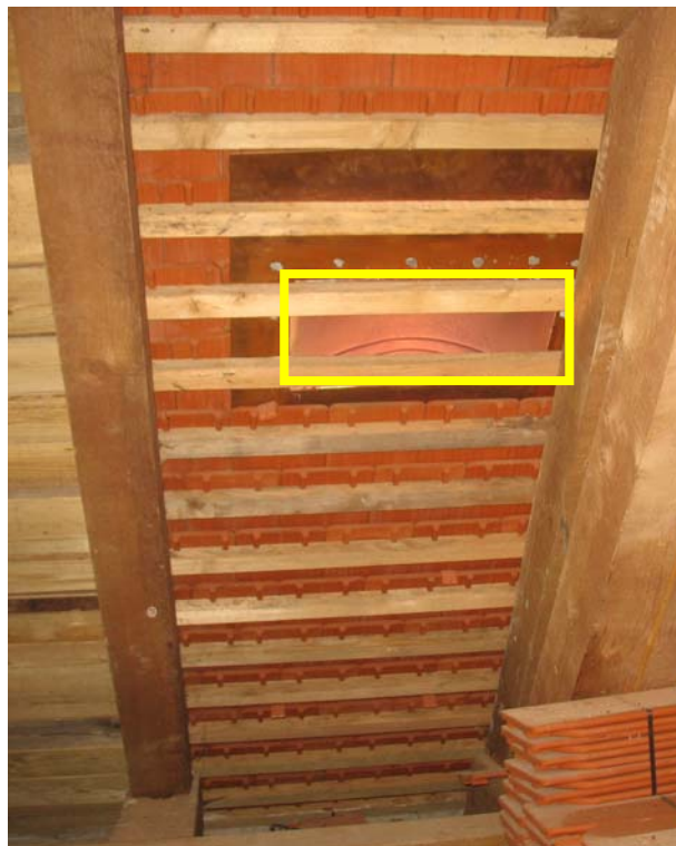
Slika 24. "Zračniki" oz. "netopirske odprtine" na SV strani strehe cerkve sv. Peter in Pavel v Brestanici bi morda lahko služili kot preletne odprtine za netopirje, vendar so pregrajeni s strešnimi letvami. Z rumenima kvadratoma so označeni deli, ki bi se morali nujno porezati (foto: Primož Presetnik, 27.6.2009).
