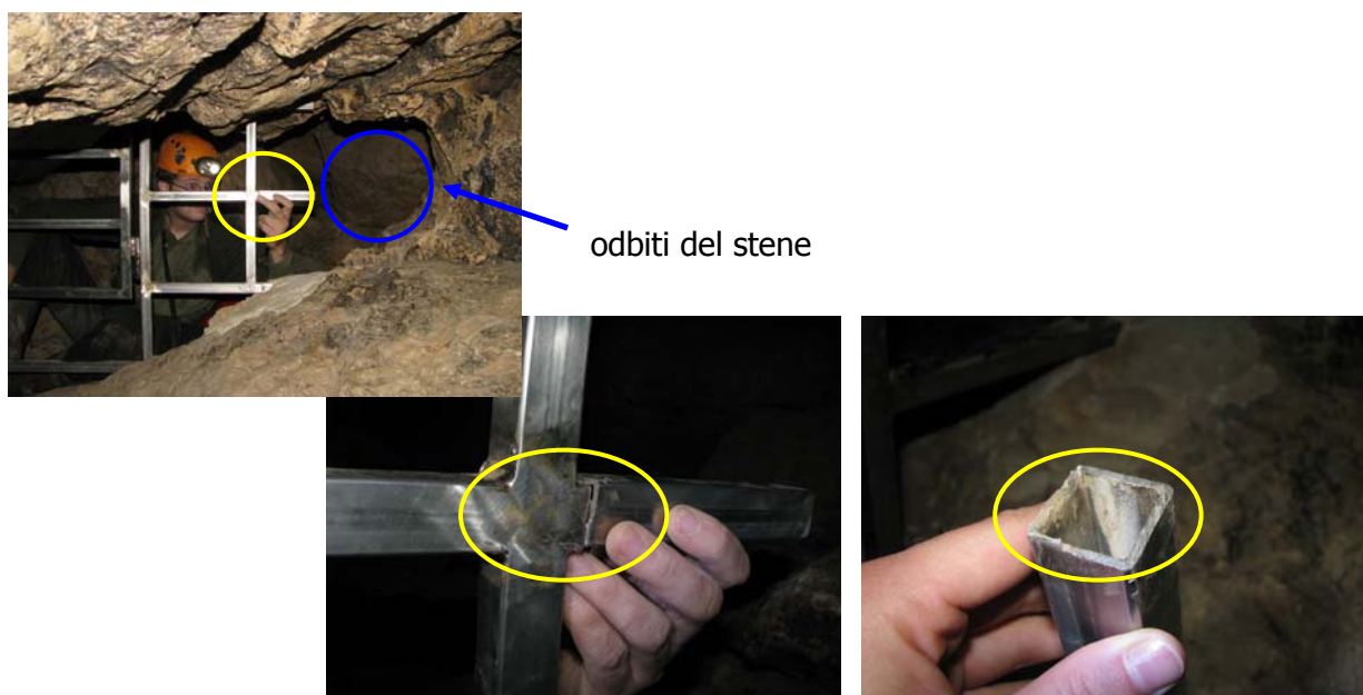
Slika 25. Poškodovana rešetka in označen odbiti del stene na vhodu v Osapsko jamo (foto. Monika Podgorelec, 23.6.2009).
