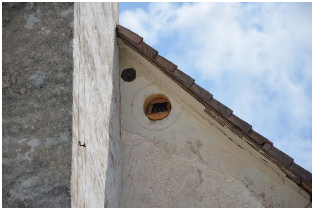
Slika 14: Odprta lina omogoča lažji dostop na podstreho cerkve Marije vnebovzete na Svetem Vrhu (foto: Simon Zidar, 22. 6. 2016).
