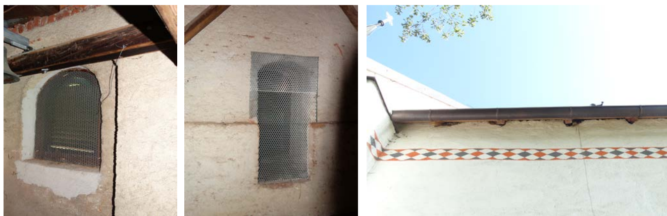
Slika 12: a) Zamrežena polkna na zvonišču, b) prehod med zvonikom in podstreho ter c) majhne reže med špirovci strehe in zidom, ki so domnevne preletne odprtine netopirjev v cerkvi sv. Mohorja in Fortunata v Podgori (foto: Primož Presetnik, 21. 7. 2016).
