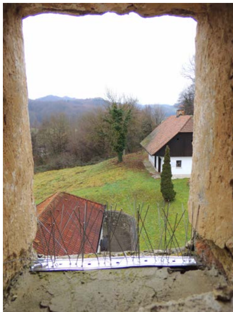
Slika 16: Odprta line na zvoniku in nameščene bodice proti pristajanju golobov na lini zvonika cerkve Device Marije na Pesku v Slakah (foto: Dušan Klenovšek, 9. 12. 2015).
