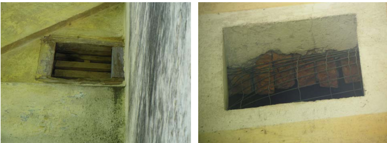
Slika 13: Zaprte odprtine na podstrehi in zamrežene line na zvoniku cerkve sv. Florjana v Trzinu (foto: Jasmina Kotnik, 7. 7. 2016).
