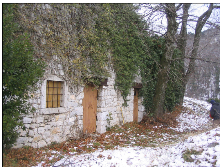
Slika 25. Hlev z zastavljenimi okni in vrati. (Foto: P. Presetnik, 22.2.2005) (za umestitev v grajski kompleks glej Sliko 1)
