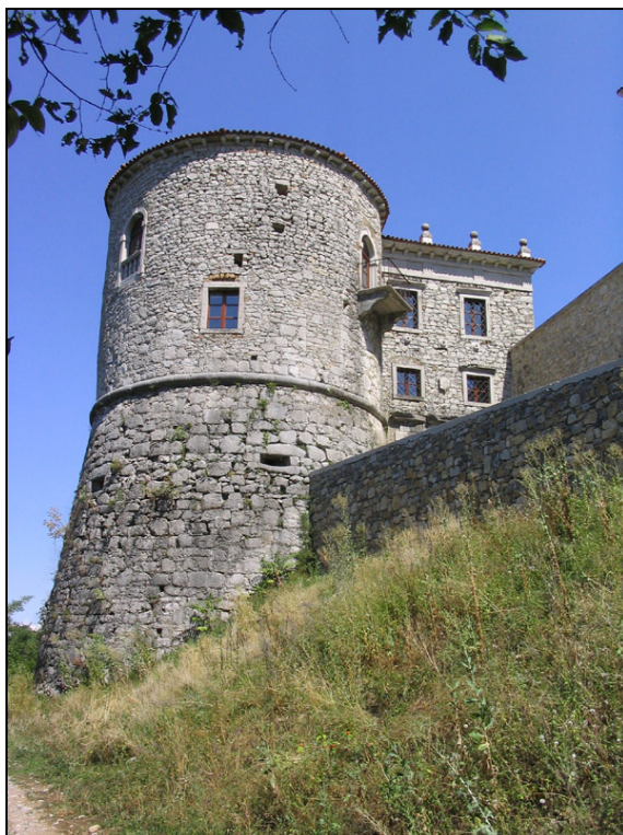
Slika 14. Vhodni stolp in vhodno poslopje gradu Rihemberk. (Foto: P. Presetnik, 23.7.2004) (za umestitev v grajski kompleks glej Sliko 1)
