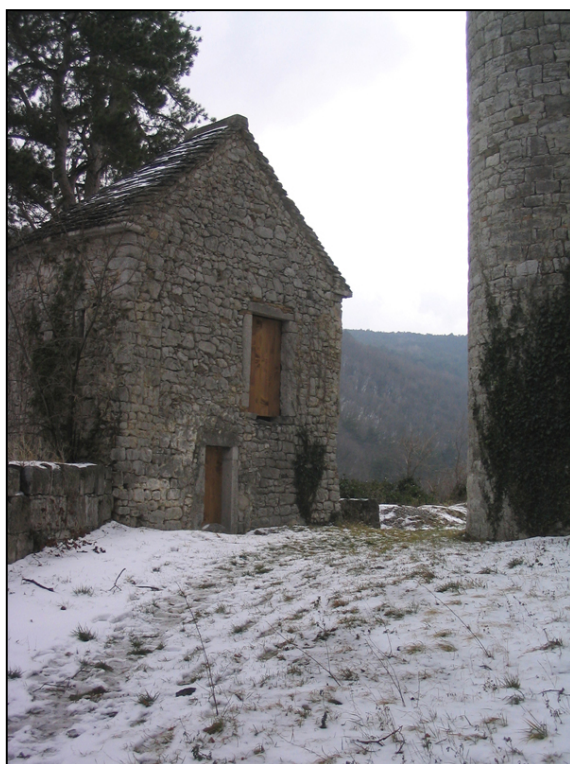
Slika 24. Rondela 20 z zastavljenimi odprtlinami in vrati. (Foto: P. Presetnik, 22.2.2005) (za umestitev v grajski kompleks glej Sliko 1)
