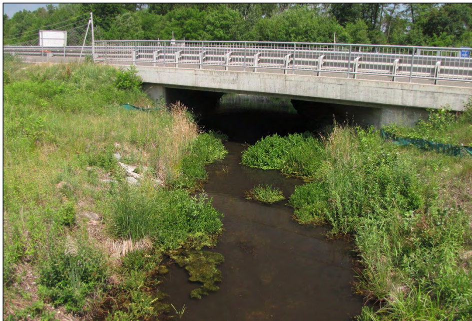
Slika 6: Prepust Črnega potoka pod avtocesto (foto: A. Šalamun, 08. 06. 2016).
