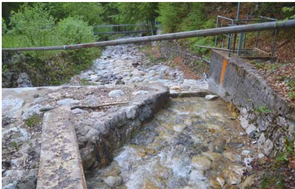
Slika 7: Mala hidroelektrarna (MHE) je velik poseg v naraven vodni ekosistem. Z betonom in kamni utrjene brežine in dno struge ter neupoštevanje ekološko sprejemljivega pretoka trajno osiromaši biotsko in habitatsko pestrost, pridobljena električna energija pa je daleč od tako imenovane »zelenе energije«. Foto: Mihael Jožef Toman.
