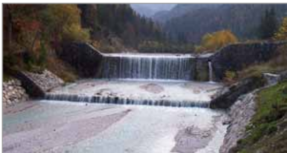
Slika 1: Pišnica v Kranjski Gori - velika zaplavna pregrada iz kamna v betonu (foto arhiv VGP d.d., 2005)
