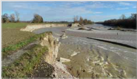
Območje porušitve leve brežine odvodnega kanala v Forminu (A. Suhadolnik)
