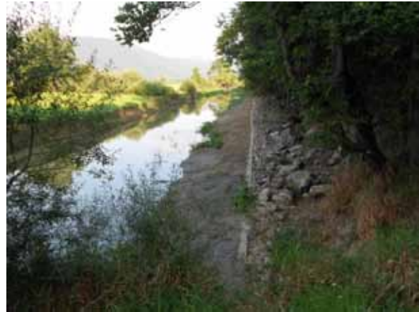
Slika 10: Sanacija prelivnega polja Milavčevi ključi številka 31 in 32 – po izvedbi (foto: I. Lampič)
