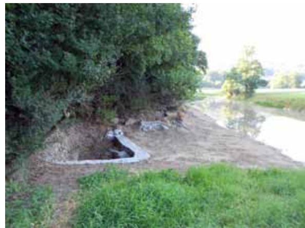
Slika 8: Sanacija prelivnega polja Milavčevi ključu številka 33 – po izvedbi (foto: I. Lampič)
