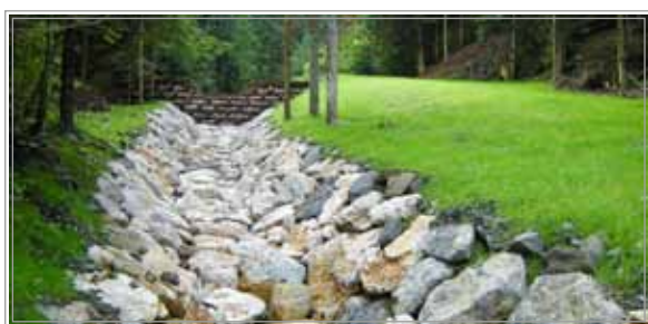
Slika 2: Pritok Davče v Zgornji Davči - manjša zaplavna pregrada iz dvostenskih lesenih kašt, polnjenih s kamnom (foto arhiv VGP d.d. 2012)
