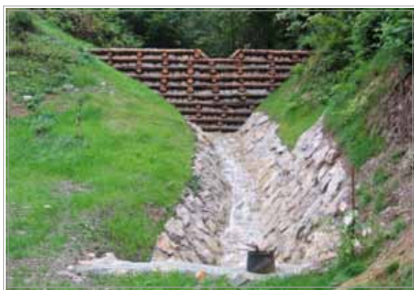
Slika 4: Pritok Češnjice v Rudnem - zaplavna pregrada iz dvostenskih lesenih kašt, polnjenih s kamnom (foto arhiv VGP d.d. 2010)
