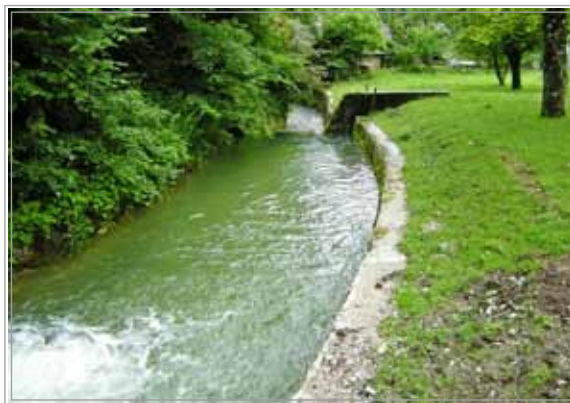
Slika 7: Hudournik Bezena nad vasjo Nomenj v Bohinju - pogled dolvodno na obzidan zaplavni usedalnik ter iztočni prag (foto arhiv VGP d.d. 2010)
