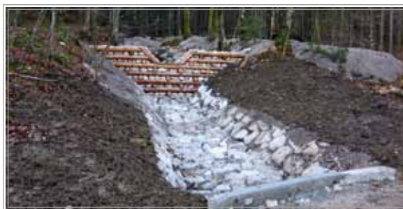
Slika 5: Pritok Bohinjskega jezera izpod Vogla - manjša zaplavna pregrada iz dvostenskih lesenih kašt, polnjenih s kamnom (foto arhiv VGP d.d. 2008)
