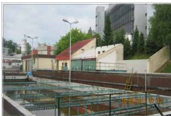
foto iz časa gradnje: rušenje upravnega objekta
