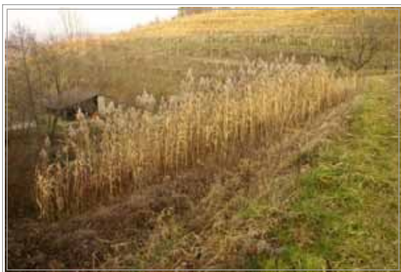
Slika 9: Telo nasute homogene pregrade je popolnoma nasičeno z vodo in na zračni strani gosto poraščeno z vodoljubnimi rastlinami. Pod pregrado stoji turistični objekt!
