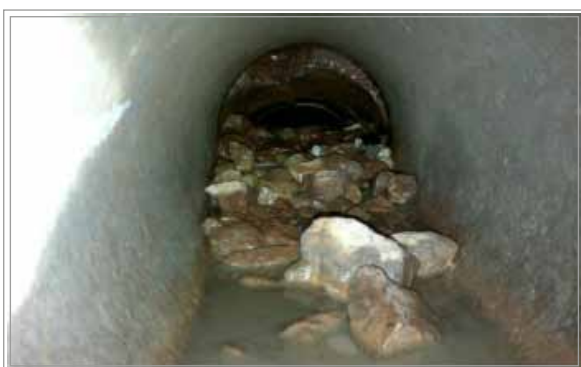
Slika 17: Posedla cev drenažnega sistema
