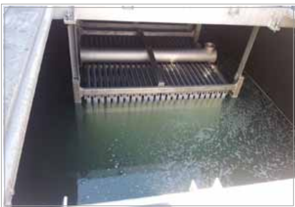
Iz časa gradnje: montaža membran
