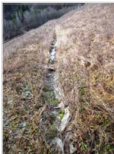
Slika 8: Brežine pregrade so gosto poraščene z večletnim rastjem, iz poškodovanih koritnic površinska voda stalno pronica v notranjost pregrade.
