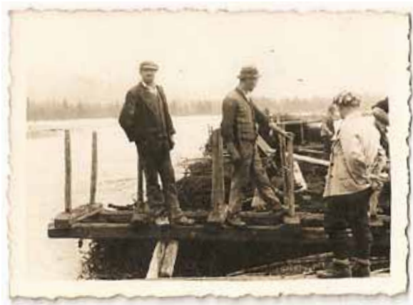
Izdelava vodilne zgradbe iz fašinskih tonjač
