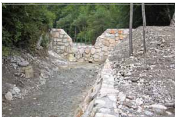
Slika 15: Nidrarska grapa v Podroštu nad Železniki - primer zelo učinkovite zaplavne pregrade z grabljastim prelivom – relativno majhna pregrada, zgrajena v ožjem skalnem profilu, ustvarja zaplavni prostor z volumnom do 5.000 m 3 . Dovožna cesta je speljana prek krila pregrade (foto arhiv VGP d.d. 2009).
