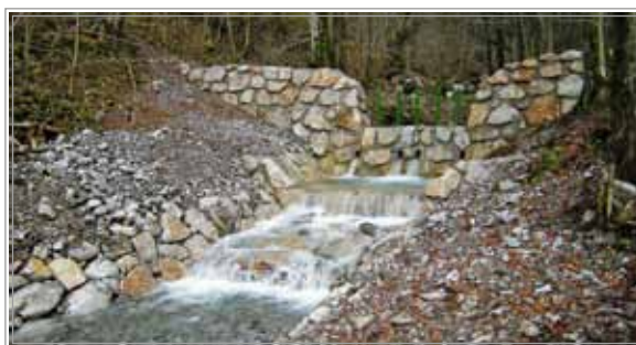
Slika 6: Zaledje hudournika Plenšak pri Železnikih - zaplavna pregrada iz kamna v betonu, z grabljamim prelivom (foto arhiv VGP d.d. 2012)
