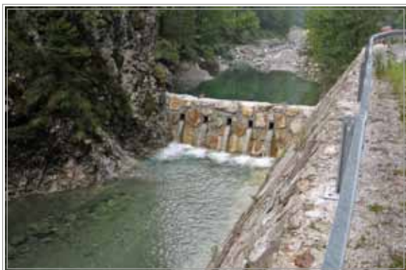
Slika 14: Davča dolvodno od izliva Zale - primer zelo učinkovite zaplavne pregrade – relativno majhen objekt, zgrajen v ozkem skalnem profilu, ustvarja zaplavni prostor z volumnom 3.300 m 3 . Dovož do zaplavnega prostora je 200 m gorvodno, z glavne ceste (foto arhiv VGP d.d. 2010)
