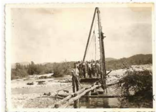
Zabijanje pilotov za bodočo vodilno zgradbo
