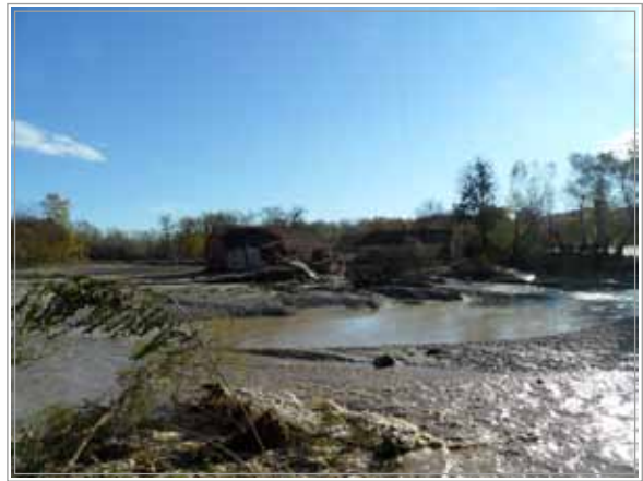
Območje porušitve med Dravo in kanalom v Forminu (A. Suhadolnik)
