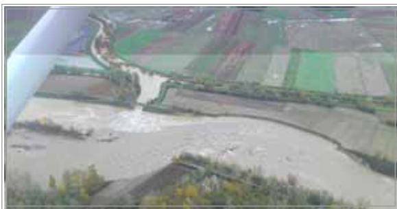
Porušitev odvodnega kanala pod HE Formin z letala (B. Supej)
