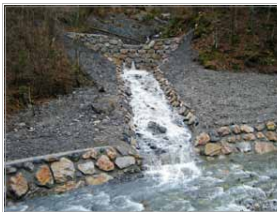
Slika 11: Varžetov graben (pritok zadnje Sore pod Sorico) - zaplavno ustalitvena pregrada, katere zaplavec bo podprl in s tem umiril plazenje pobočij v grapo - zaplavni prostor v prihodnje ne bo praznjen (foto arhiv VGP d.d. 2011)
