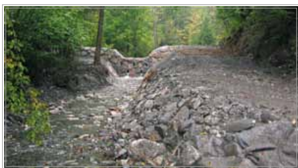
Slika 3: Mačeha (pritok Dašnice) nad Železniki - srednje velika zaplavna pregrada iz kamna v betonu (foto arhiv VGP d.d. 2011)
