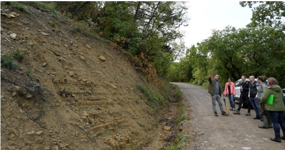
Slika 3: Ogled rastišč in izvedenih posegov na območju cestnega odseka Škrline - Novi Brič.
