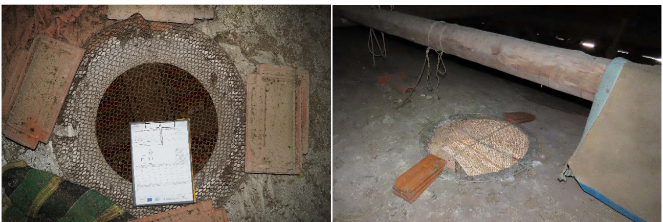
Slika 14: Primer zaščite pred vstopom netopirjev skozi odprtino za lestenev v cerkveno ladjo, na desni sliki se vidi tudi preproga, s katero verjetno zaradi toplotne izolacije pozimi pokrijejo odprtino (cerkvi v Dolenjih Novakih in v Cerknem, izvedba upravljalec). (foto: Aja Zamolo, Primož Presetnik)
