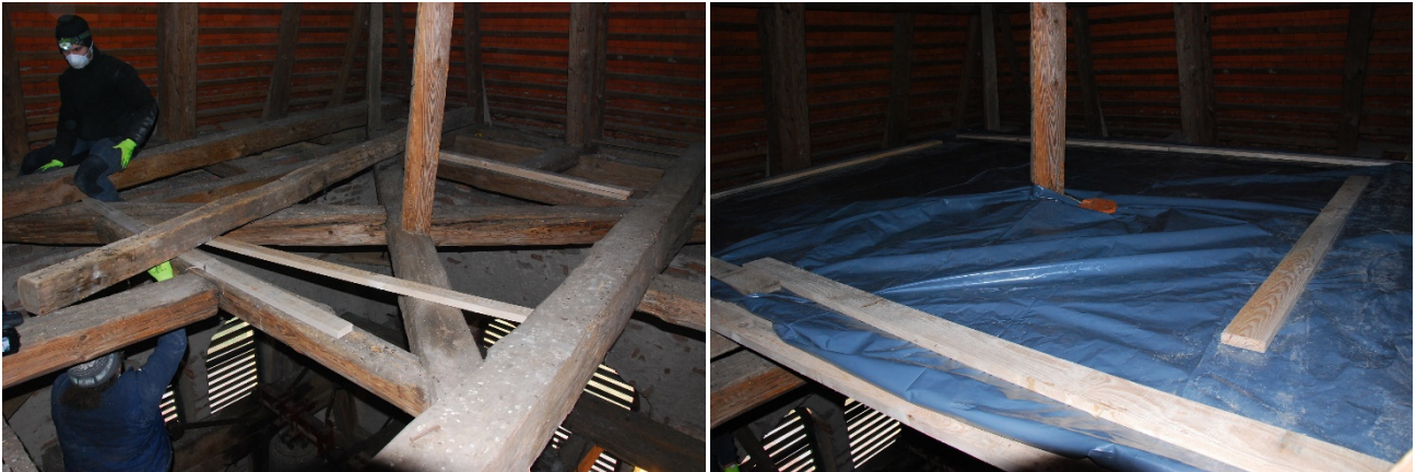
Slika 12: S postavitvijo podesta nad zvoniščem se onesnaženje zvonišča z netopirskim gvanom močno zmanjša (cerkev na Gradu, izvedba v projektu Goriška krajina ). (foto: Gregor Domanjko)
