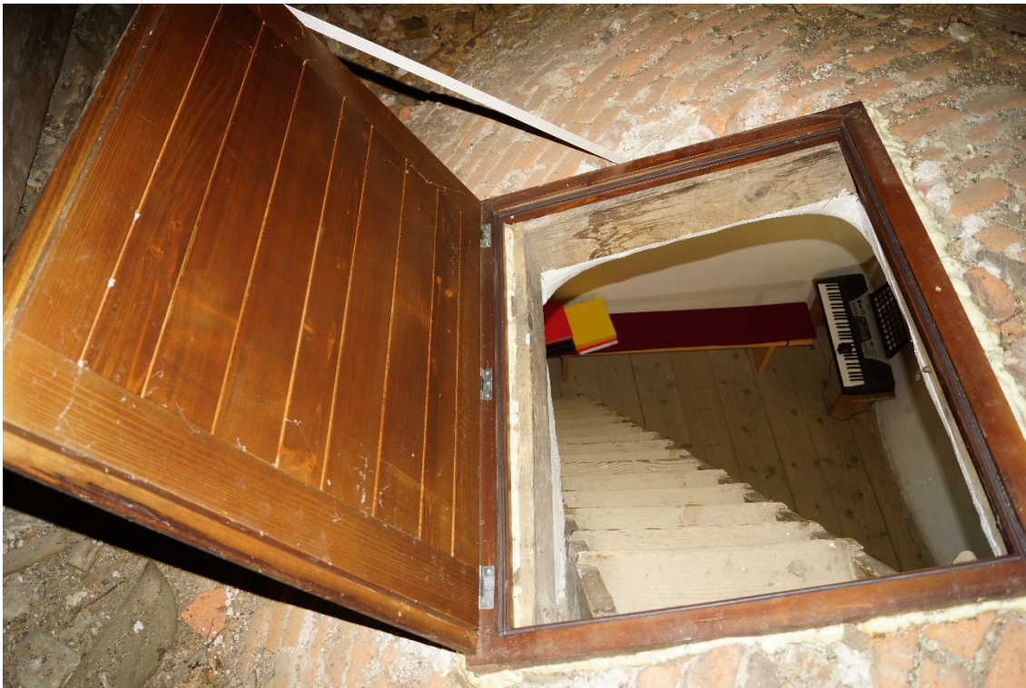
Slika 18: Primer zaprtja prehoda iz kora na podstreho na neravni površini in na način, da gvano ne pada v spodnji prostor (cerkev sv. Križ v Iški vasi, izvedba javna služba). (foto: Aja Zamolo)
