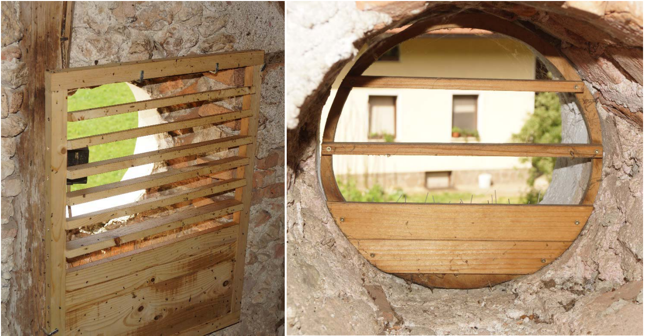
Slika 21: Posebna polkna (pogosto v kombinaciji z bodicami proti pristajanju golobov) omogočajo prelete netopirjev, preprečujejo ali vsaj otežujejo pa vstop golobom; levo – ožje reže zadostujejo za vstop navadnih netopirjev, desno – širše reže so nujne za prelete malih podkovnjakov (cerkvi v Češnjevku in sv. Mihael v Iški vasi, izvedba Navadni netopirji – prav posebni sosedje! oz. javna služba). (foto: Aja Zamolo)
