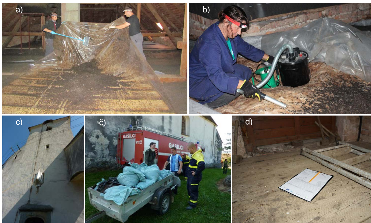
Slika 22: Prikaz a) srednje enostavnega čiščenja posebnega podesta z zlaganjem ponjave, b) čiščenje z industrijskim sesalcem, c, č) tehnično zahtevno čiščenje velike količine gvana d) z netopirskim gvanom le malenkostno onesnaženo zvonišče (Podružnična šola Stoperce, cerkev v Završah, cerkev v Sinji Gorici), (foto: a, b: Monika Podgorelec, c, č: arhiv ZRSVN OE Celje, d: Aja Zamolo).
