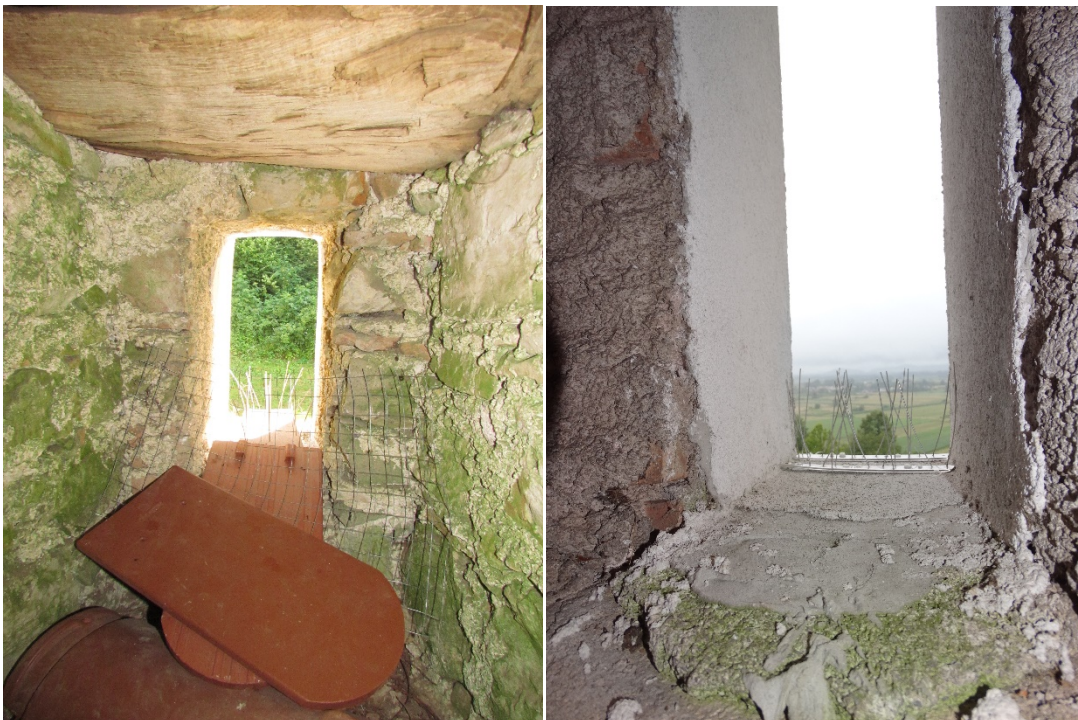
Slika 20: Primer nameščenih bodic proti pristajanju golobov (cerkvi sv. Janez Krstnik v Podkraju in na Jezeru, izvedba upravljalca oz. javna služba). (foto: Primož Presetnik)
