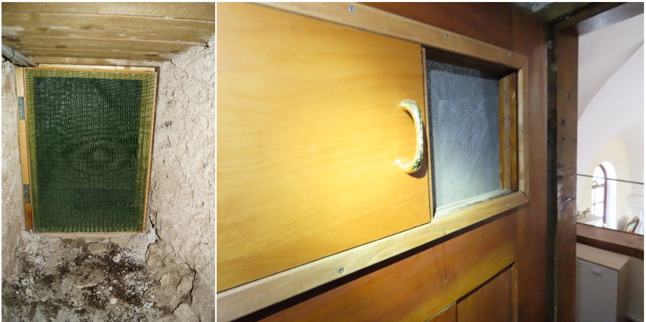
Slika 19: Primer zaprtja prehoda iz kora na podstreho s popolnoma mrežastimi vrati ali vrati, ki imajo poleg zamreženega okna tudi loputo, ki se pozimi zapre (varčevanje s toploto). Zračenje je v obeh primerih zagotovljeno, netopirji pa se v fine mreže ne morejo zaplesti (cerkvi v Bočni in veliki Ligojni, izvedba upravljalca). (foto: Aja Zamolo, Primož Presetnik)
