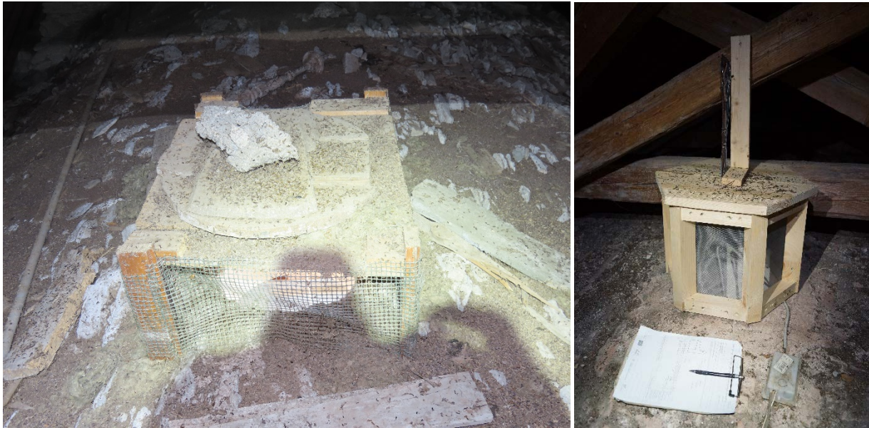
Slika 15: Rešitev, ki preprečuje padanje gvana v cerkveno ladjo skozi odprtino za lesteneč (cerkvi v Lazcu in Jakovici, izvedba upravljalec oz. v projektu KRAS.RE.VITA ). (foto: Primož Presetnik, Aja Zamolo)
