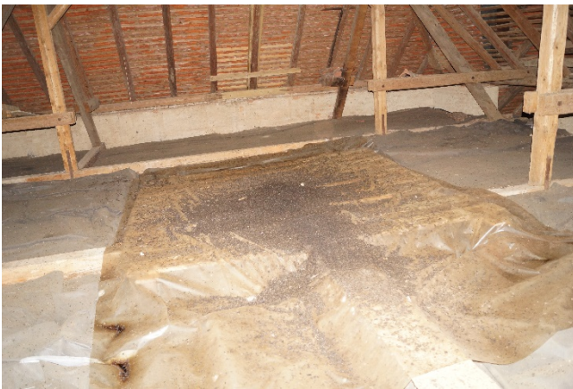
Slika 13: Že postavitev folije olajša odstranjevanje gvana in zmanjša možnost dodatnega onesnaženja v primeru morebitnega zamakanja, vse to pa lahko olajša še postavitev podesta (šola v Stopercah, izvedba javna služba in prostovoljci). (foto: Aja Zamolo)
