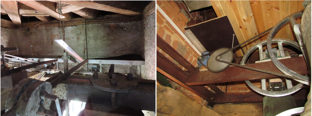
Slika 17: Zaščita verig in ostalih pogonskih mehanizmov zvonov z aluminijastimi profili ali pa leseno polico (cerkvi v Goriči vasi in Kobilju, izvedba v projektu Navadni netopirji – prav posebni sosedje! oz. javna služba). (foto: Primož Presetnik)
