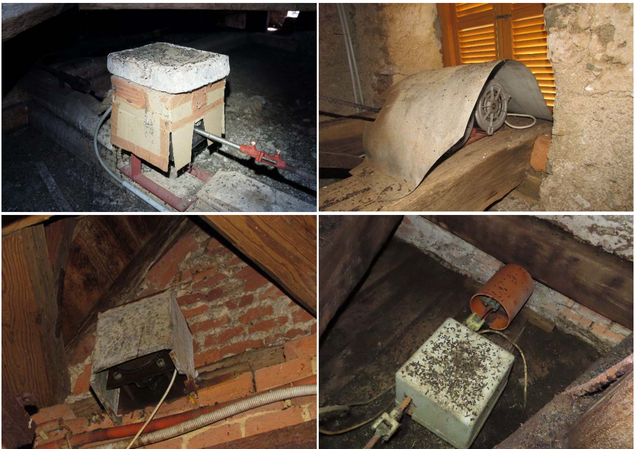
Slika 16: Primeri »naredi sam« zaščit, ki so jih upravljalci postavili, da bi preprečili obremenjenost elektromotorjev in zobnikov urnega mehanizma z netopirskim gvanom (cerkve na Igu, Blečjem vrhu, Kobilju, Mežici, izvedba upravljalec). (foto: Aja Zamolo, Primož Presetnik)
