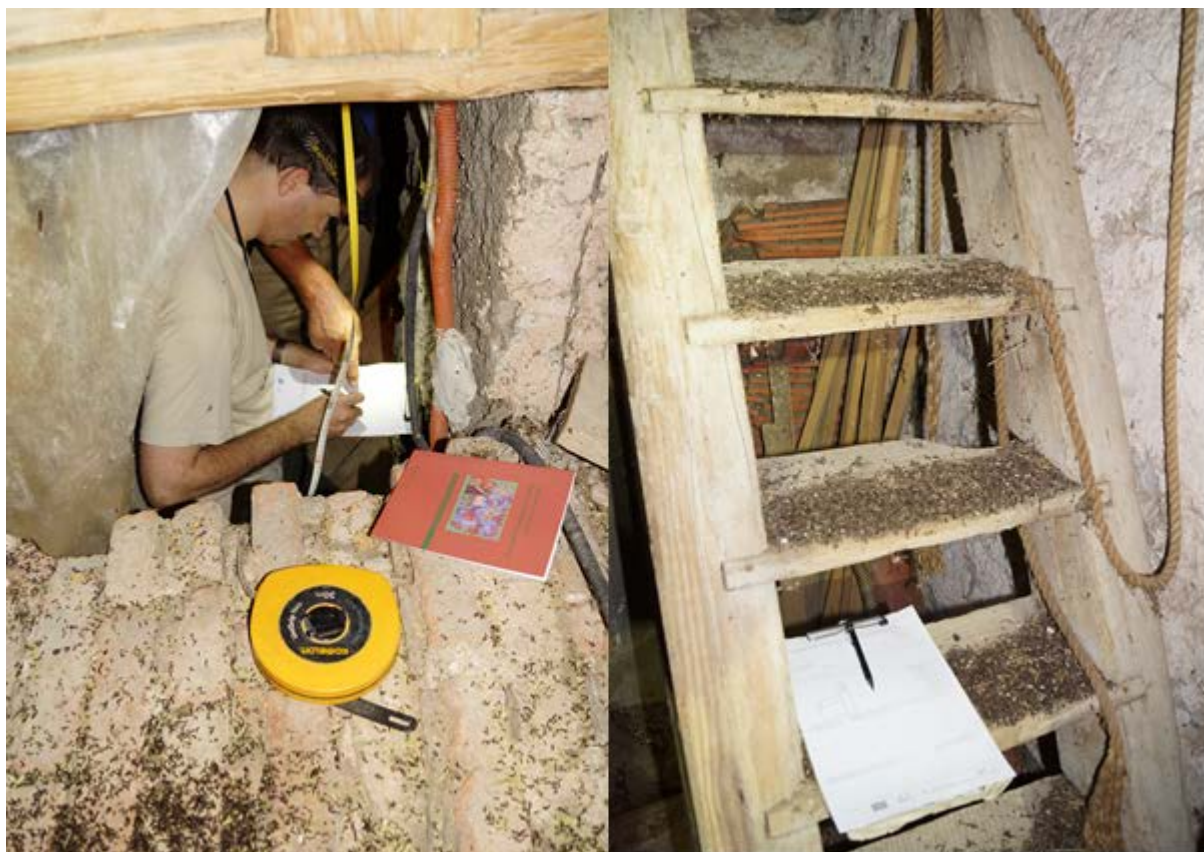
Slika 3: Popisovanje obremenjenosti z gvanom in načrtovanje možnih ukrepov za preprečevanje obremenjenosti z gvanom (levo) ter primer popisne površine - stopnišča kot pohodne funkcionalne površine obremenjene z gvanom (desno). (foto: Aja Zamolo)
