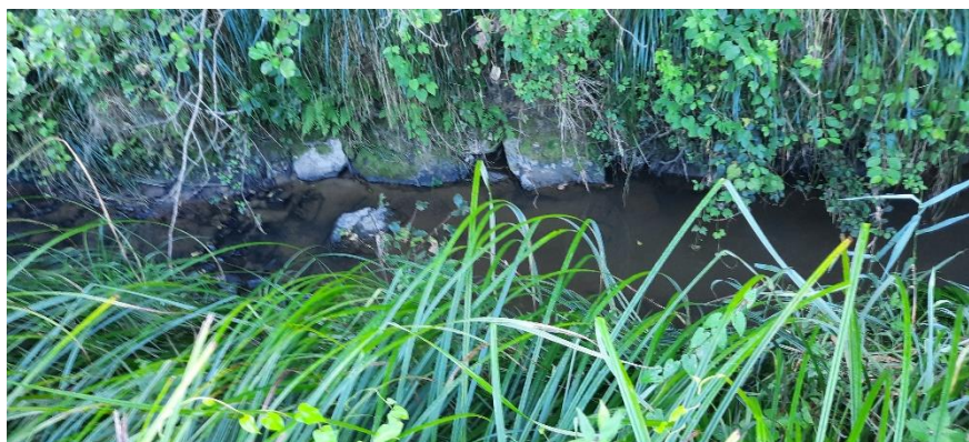
Slika 36. Utrditev brežine v peti na potoku Dobje (DRSV, 2021).
