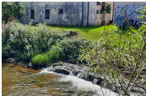
Slika 15. Prag na lokaciji D7 prag Mlače je umeščen neposredno ob stanovanjske objekte (Avtor: DRSV, 2021)
