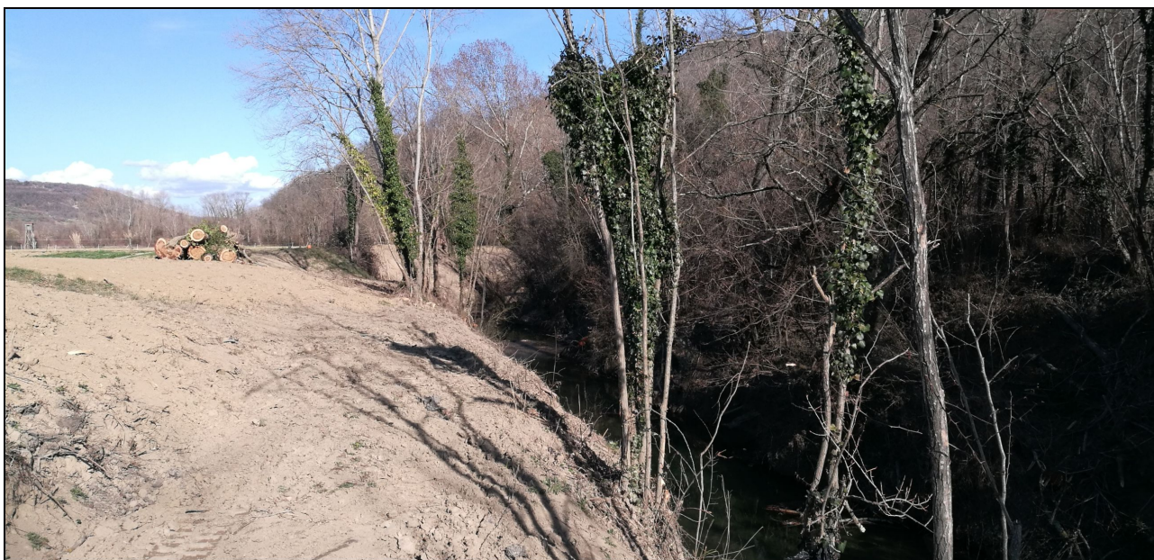
Slika 7: Odložen material na brežine reke Dragonje bo v nekaj letih erodiran v strugo (foto: Ali Šalamun, 8. 3. 2019)
