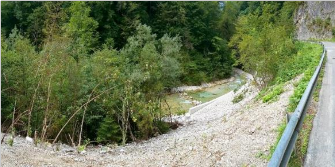
Slika 53: Primer posegov v sestoji habitatnega tipa 91E0* ob Kamniški Bistrici, kjer je bil neposredno ob strugi zgrajen podporni zid. Nad njim je bila zgrajena utrjena brežina regionalne ceste Stahovica-Kamniška Bistrica. Podporni zid brežine je v funkciji usmerjanja toka reke Kamniške Bistrice in preprečevanja vodne erozije na cestni brežini ter služi tudi kot mehanski stabilizator cestne brežine. Z gradnjo ceste in nasutjem materiala v cestni brežini so bili povsem ali vsaj deloma degradirani sestoji habitatnega tipa 91E0*. (foto: Lado Kutnar)
