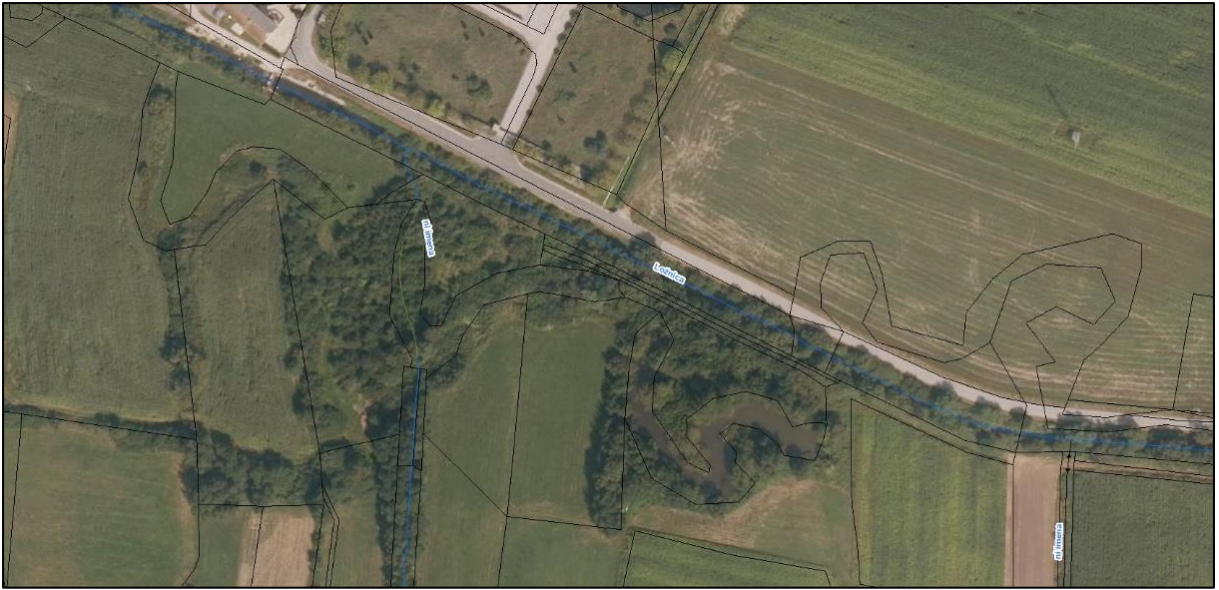
Slika 20 Lokacija izvedbe predlaganega revitalizacijskega ukrepa oživitve mrtvic v nekdanji strugi Vzhodne Ložnice (DRSV, Atlas voda, 2020)
