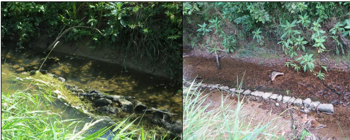
Slika 7 V dno struge Vzhodne Ložnice predstavljeno prvotno obrežno zavarovanje zaradi naravne dinamike vodotoka, (DRSV, 2020)
